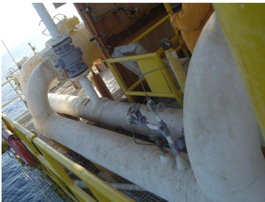
Fig. 2 Punto de interconexión, mediante Hot Tap.
